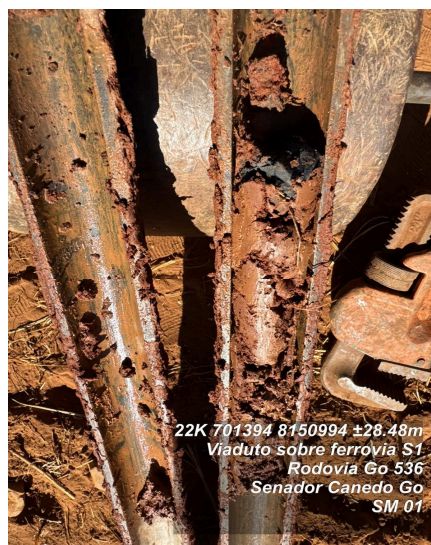
Foto 04 - Vista da execução da sondagem.
