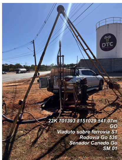
Foto 03 - Vista do local da sondagem
