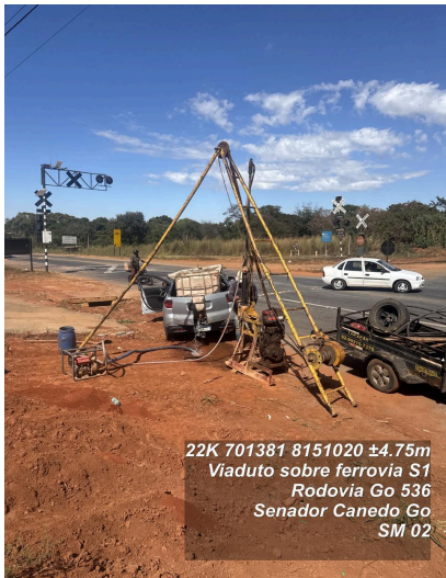
Foto 01 - Vista do local da sondagem
