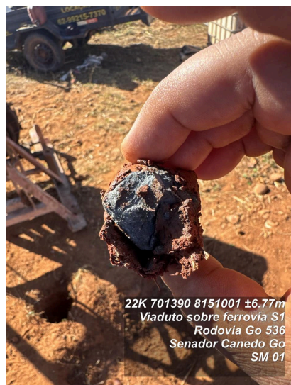
Foto 02 - Vista da execução da sondagem.
