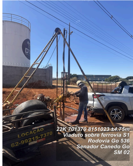
Foto 02 - Vista da execução da sondagem.
