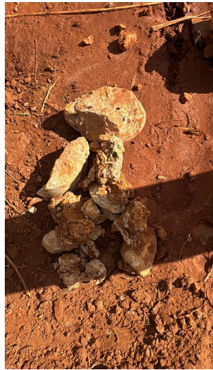
Foto 02 - Vista da execução da sondagem.
