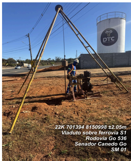
Foto 01 - Vista do local da sondagem
