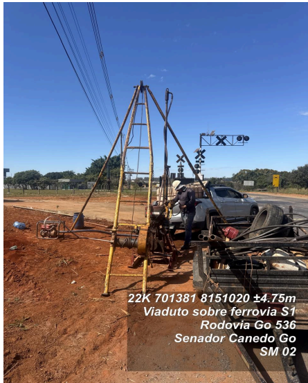
Foto 01 - Vista do local da sondagem
