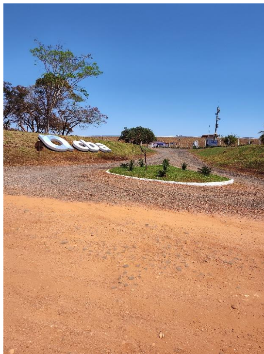
Foto 6 - km 48,9 - UHE Salto do Rio Verdinho - CBA.
