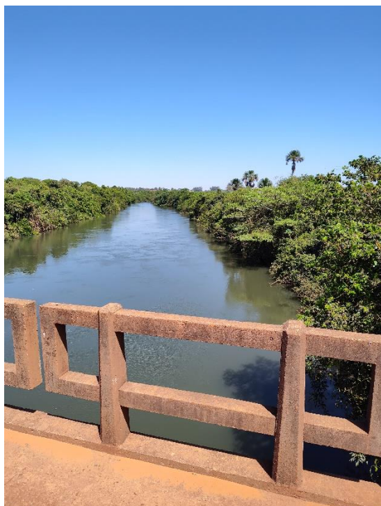
Foto 3 - km 20,7 - PCA C=80m, L=8m, A=8m.
