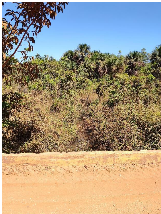
Foto 5 - km 27 - PCA C=10m, L=4m, A=4m.
