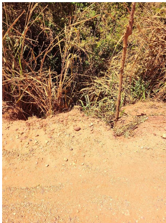
Foto 10 - km 55,9 - Bueiro tubular.
