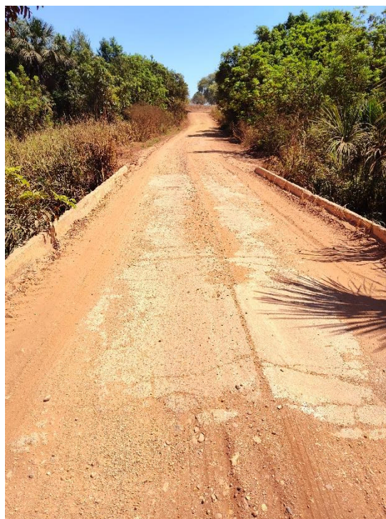
Foto 4 - km 27 - PCA C=10m, L=4m, A=4m.
