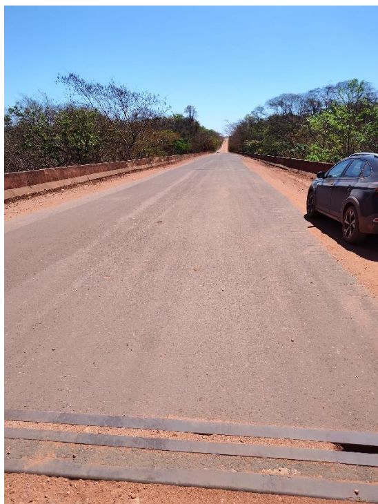
Foto 7 - km 49,3 - PCA C=170m, L=12m, A=15m.
