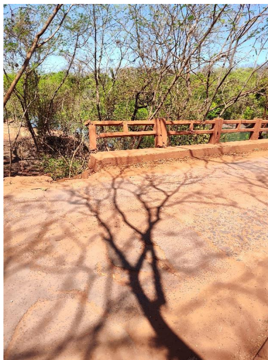
Foto 12 - km 65,9 - Fim do trecho.
