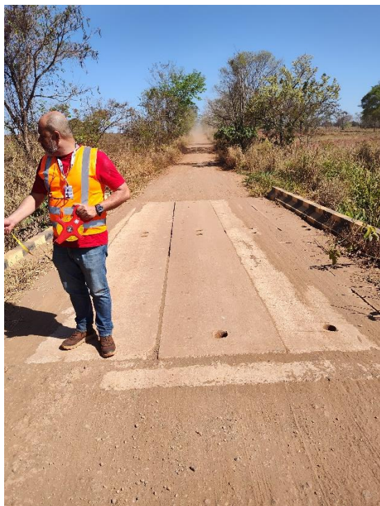
Foto 9 - km 23,1 - PCA C=8m, L=5m, A=5m.
