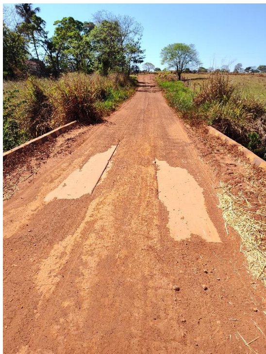
Foto 13 - km 31,9 - PCA C=10m, L=5m, A=4m.
