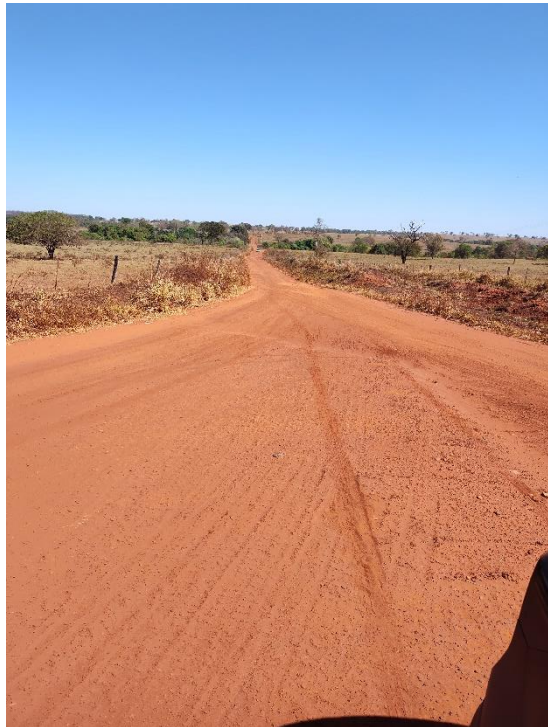
Foto 17 - km 37,4 - Fim do trecho.
