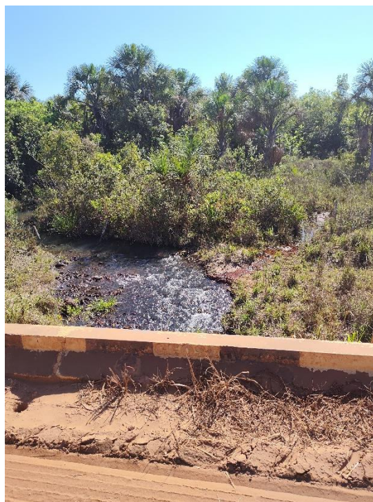
Foto 8 - km 16,1 - PCA C=8m, L=5m, A=3m.
