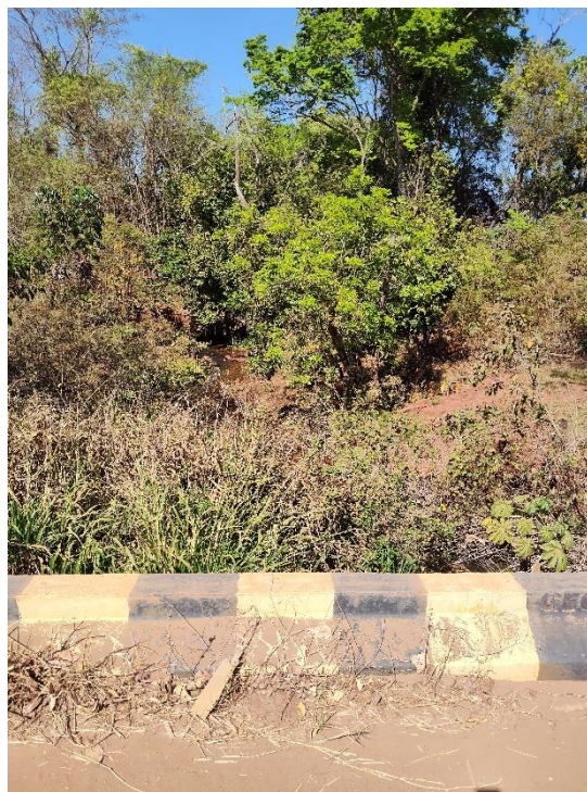
Foto 10 - km 23,1 - PCA C=8m, L=5m, A=5m.
