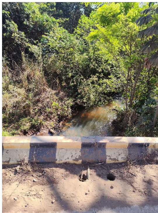
Foto 6 - km 10,4 - PCA C=10m, L=5m, A=4m.
