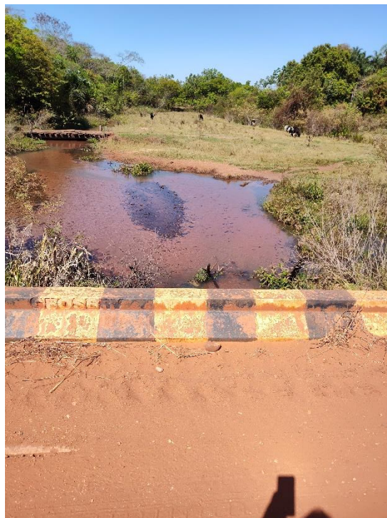
Foto 16 - km 36,9 - PCA C=12m, L=5m, A=5m.
