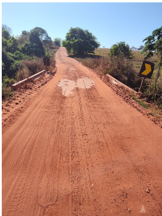
Foto 3 - km 1,9 - PCA C=6m, L=5m, A=5m.
