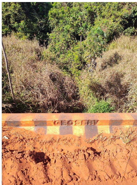
Foto 4 - km 1,9 - PCA C=6m, L=5m, A=5m.
