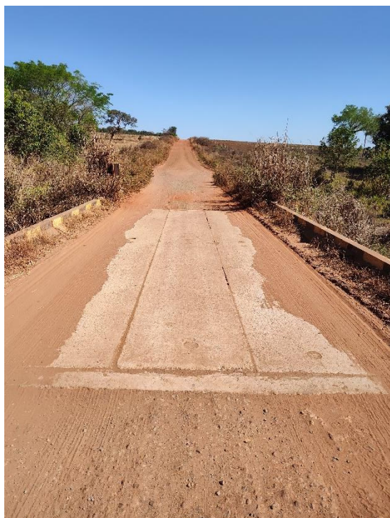
Foto 7 - km 16,1 - PCA C=8m, L=5m, A=3m.
