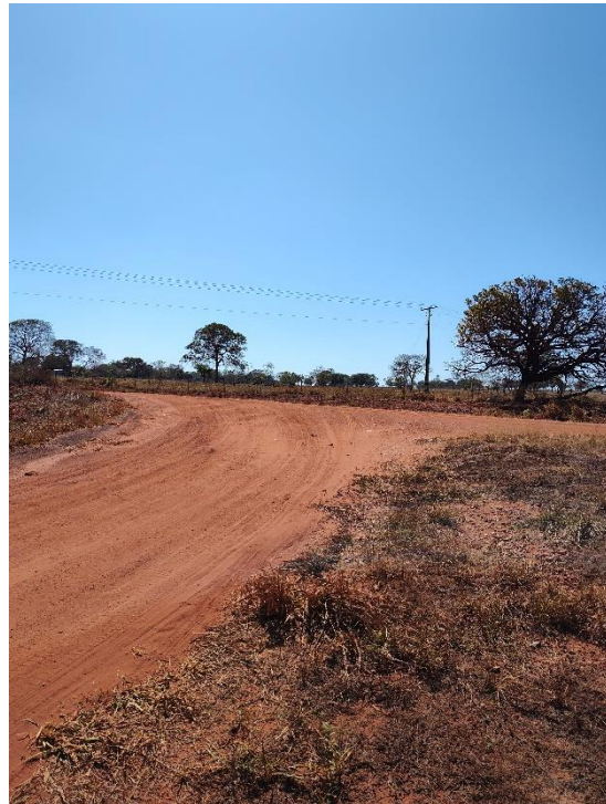
Foto 18 - km 37,4 - Fim do trecho.
