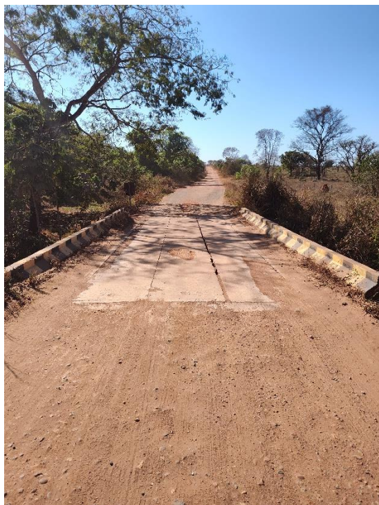
Foto 5 - km 10,4 - PCA C=10m, L=5m, A=4m.
