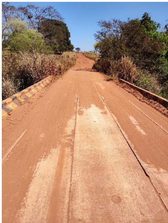
Foto 15 - km 36,9 - PCA C=12m, L=5m, A=5m.
