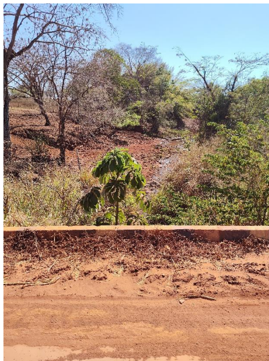
Foto 14 - km 31,9 - PCA C=10m, L=5m, A=4m.
