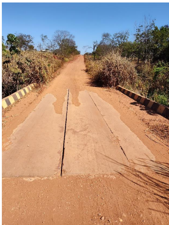
Foto 11 - km 29,3 - PCA C=10m, L=5m, A=4m.
