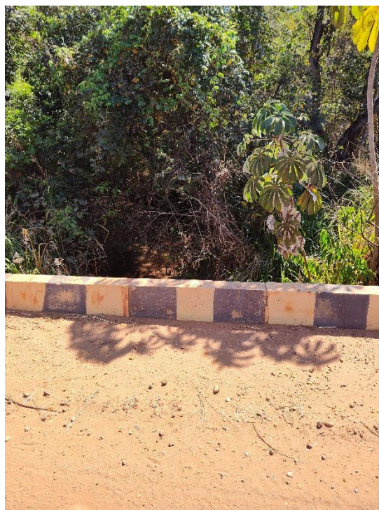
Foto 12 - km 29,3 - PCA C=10m, L=5m, A=4m.
