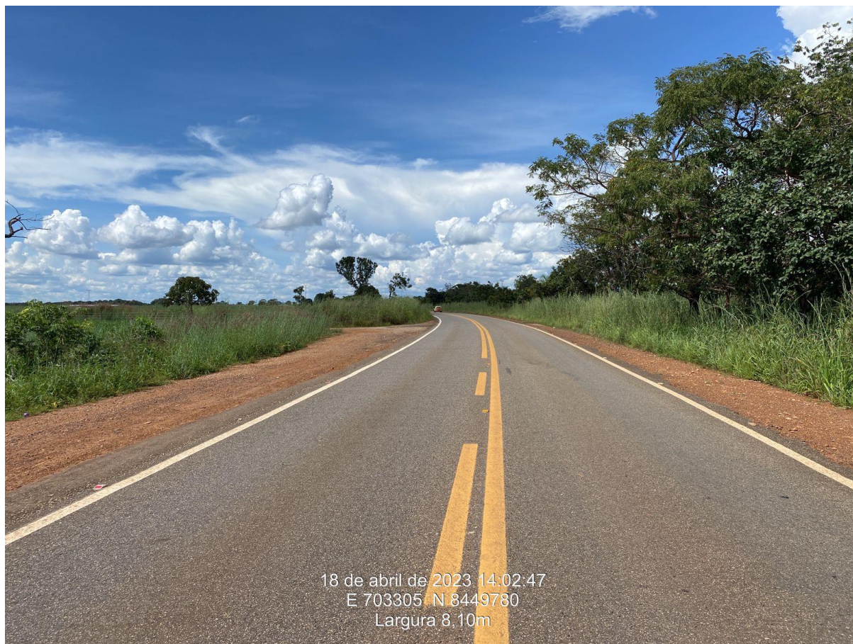
Km 0,90 – Largura da pista existente 8,10 metros.
