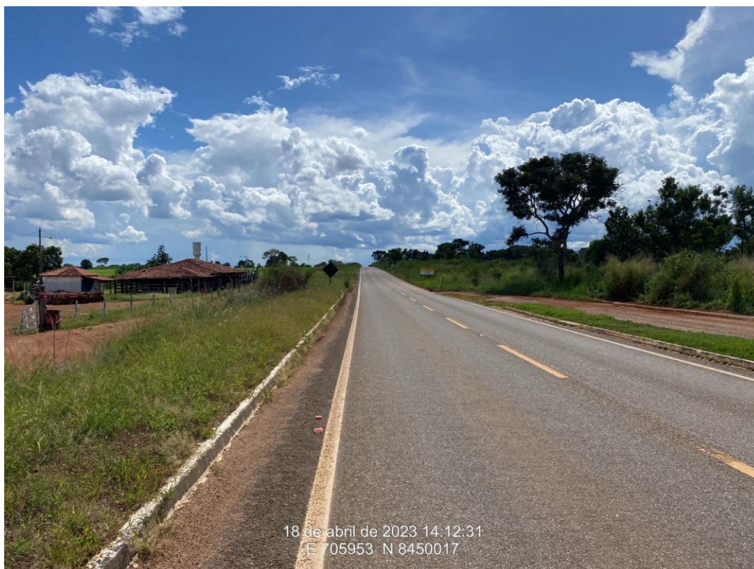
Km 6,8 – Início do segmento em área urbana (próximo ao entrocamento da BR-153).
