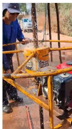
Foto 02 - Vista da execução da sondagem.
