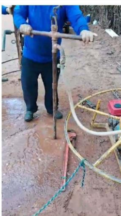
Foto 03 - Vista do local da sondagem
