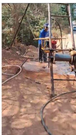
Foto 01 - Vista do local da sondagem
