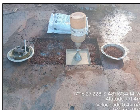
Figura 4 - Execução do ensaio de umidade e densidade in situ.
