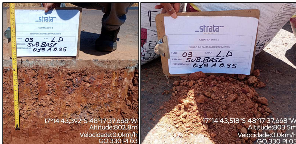
Figura 9 - Registro Fotográfico da Sub-base.
