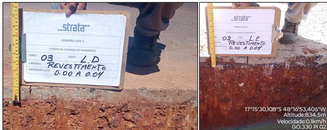
Figura 7 - Registro Fotográfico do Revestimento.
