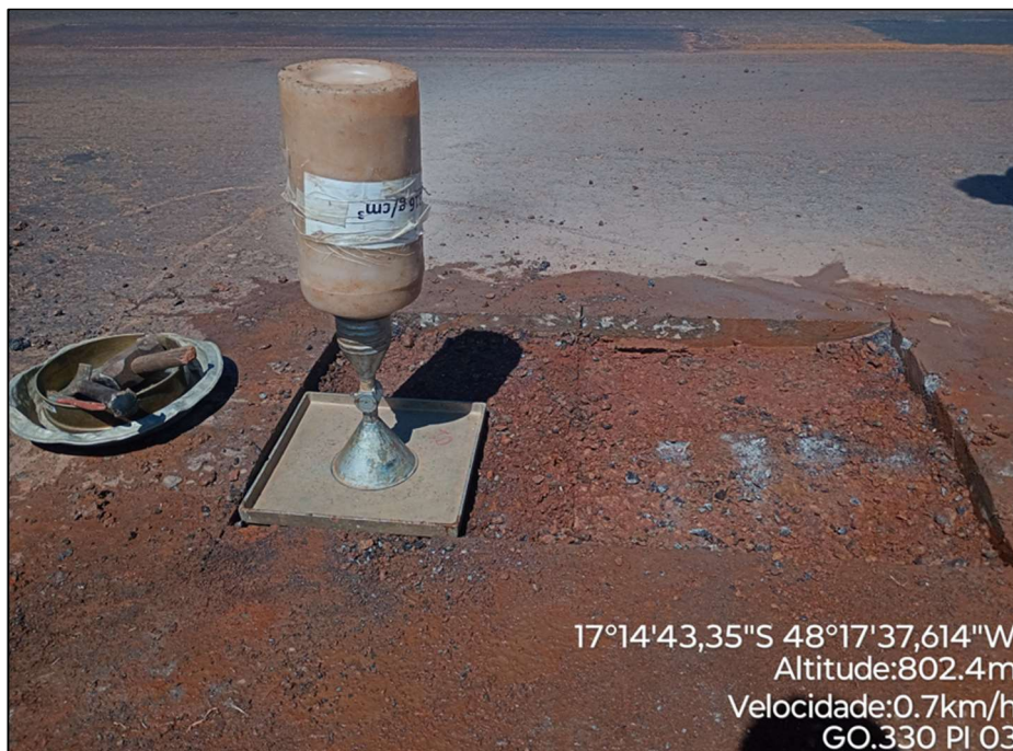
Figura 11 - Ensaio de Densidade In Situ.
