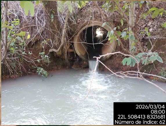
Km 35,40 BSTC Ø 1,00m Bom estado
