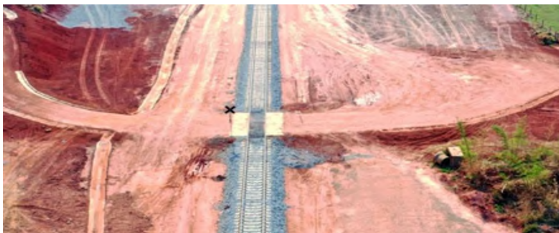
Figura 12: Obra de Conclusão da Ferrovia Norte/Sul trecho entre Santa Helena a Goianira - Fonte: O Autor.
