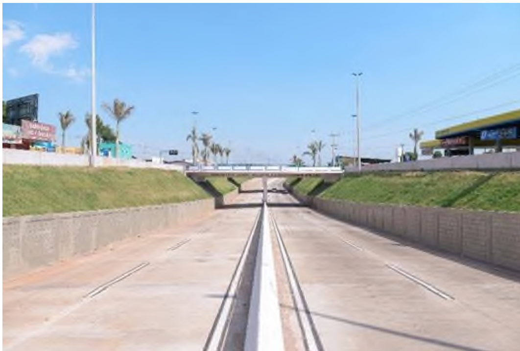
Figura 3 – Viaduto Interseção da Rodovia GO-070 com Perimetral Norte
