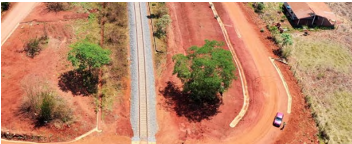
Figura 13: Obra de Conclusão da Ferrovia Norte/Sul trecho entre Santa Helena a Goianira - Fonte: O Autor.
