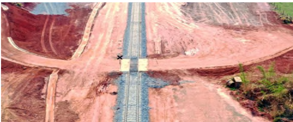
Figura 4: Obra de Conclusão da Ferrovia Norte/Sul trecho entre Santa Helena a Goianira - Fonte: O Autor.
