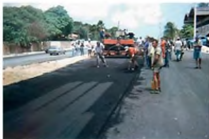
(b) Revestimento asfáltico sendo executado
