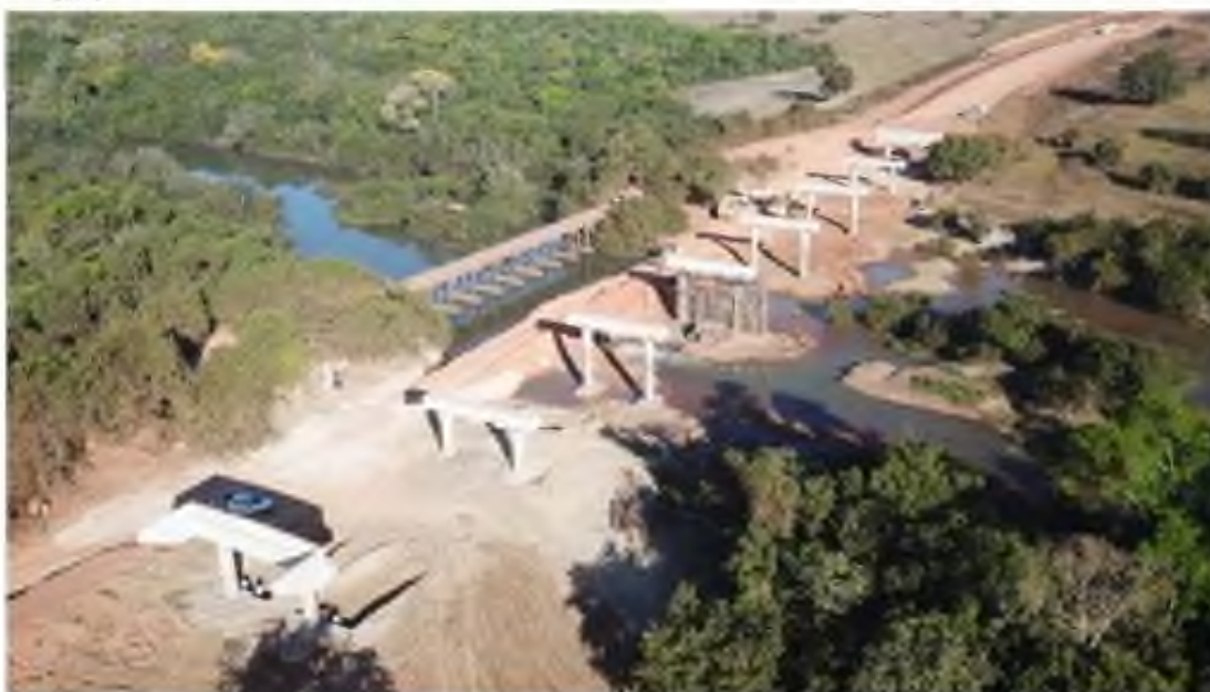
Execução da nova ponte sobre o Rio Pintado, na BR-080, ao lado da antiga ponte de madeira que atendia a região
