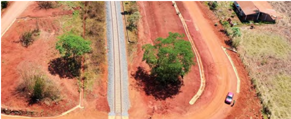
Figura 5: Obra de Conclusão da Ferrovia Norte/Sul trecho entre Santa Helena a Goianira - Fonte: O Autor.
