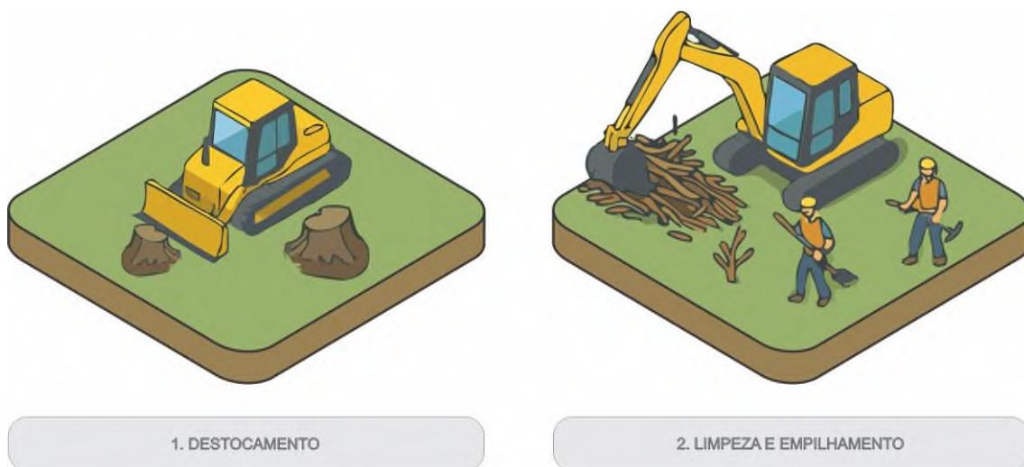
Figura 28: Destocamento, limpeza e empilhamento - Fonte: O Autor.
