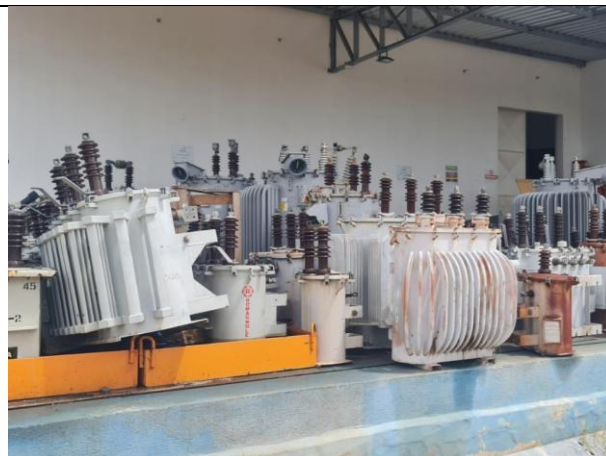
Imagem 6 - Área de Armazenamento de Equipamentos com Óleo (modelo a seguir).
