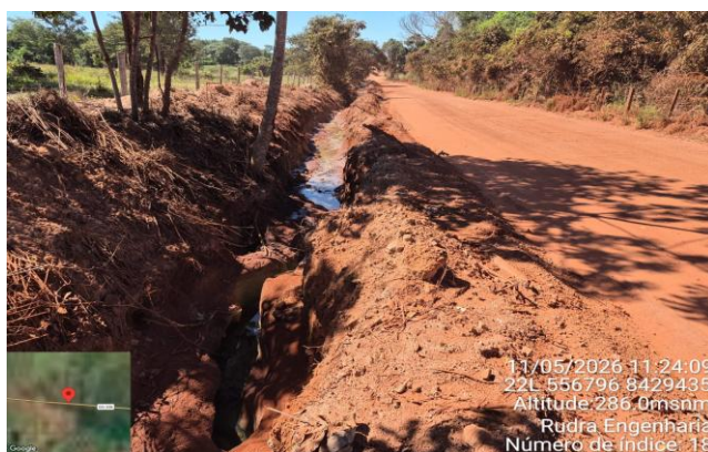
FOTO 18: km 8,7 - Drenagem sendo feita LD da pista
