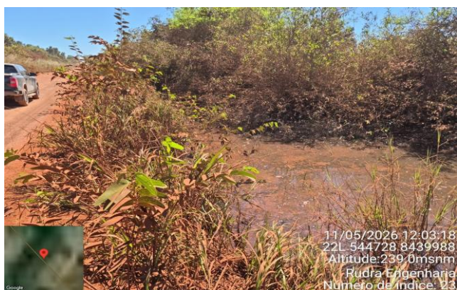
FOTO 23: km 25,6 - Provável Bueiro - Água LD pista
