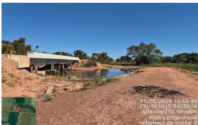
FOTO 9: Km 4,6 - Ponte Córrego Iuiú
