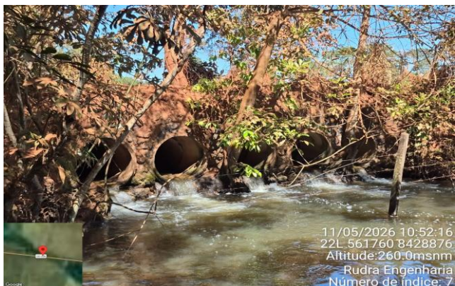
FOTO 7: Km 3,8 - BQTC - Córrego do Jacaré
