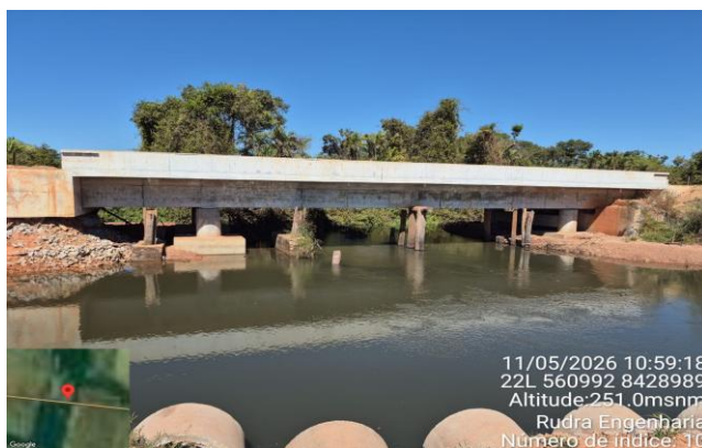
FOTO 10: Km 4,6 - Vista lateral Ponte
