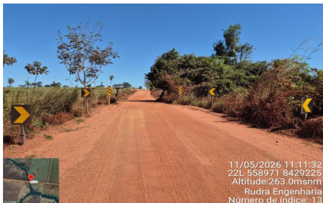
FOTO 13: Km 6,7 - Largura pista 10,0m
