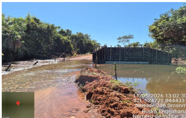
FOTO 32: km 46,9 - Vista Ponte sobre o Córrego Sobradinho
