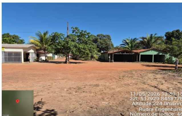
FOTO 46: km 68,4 - Depósito de gás LE
