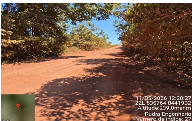
FOTO 27: km 35,0 - Provável Bueiro - Água LD pista
