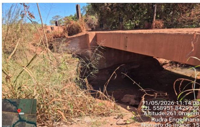
FOTO 15: Km 6,7 - Vista Lateral da ponte
