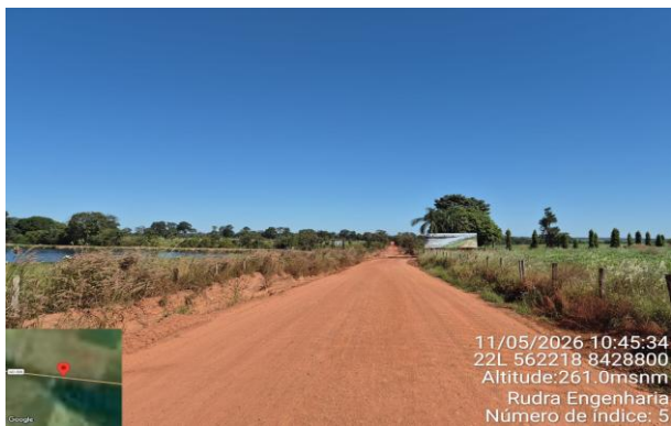
FOTO 5: km 3,4 - Vista - Represa LE - Largura da pista 8,7 m
