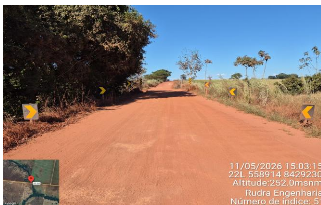
FOTO 15a: Km 6,77 - Placas Sinalização sentido contrario
