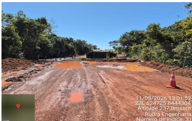
FOTO 31: km 46,9 - Ponte em construção (antiga de madeira) - Córrego Sobradinho
