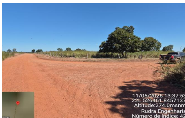
FOTO 42: km 59,6 -Largura pista 6,0m
