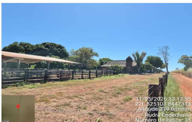
FOTO 35: km 49,9 - Curral e casa LE - Largura pista 3,7m
