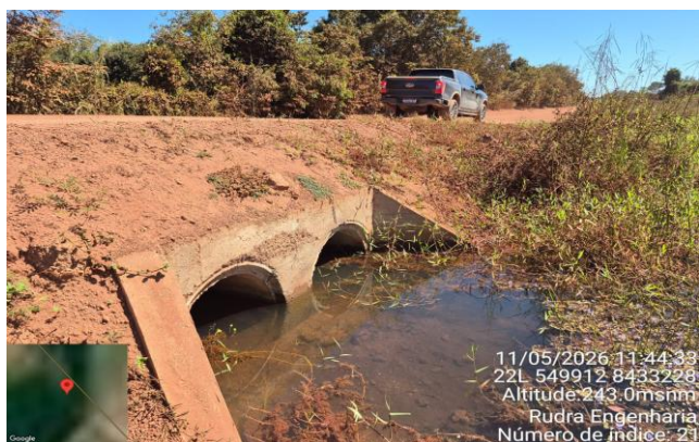
FOTO 21: km 17,1 - BDTc Ø 1,00 LD - Córrego do Brejeiro
