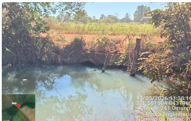
FOTO 20: km 14,7 - BDTc Ø 1,00 LD - Entupido
