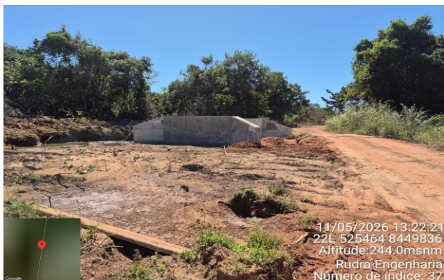
FOTO 37: km 52,3 - Ponte em construção - Sostituindo Ponte madeira C=5,0m/L=4,0/A=0,70m - Córrego Taquari
