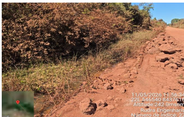
FOTO 22: km 22,6 - Provável Bueiro - Água LD pista
