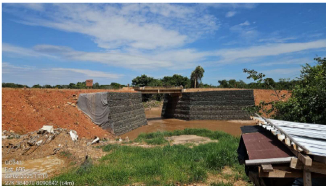
Figura 10 – Ponto obrigatório de passagem PCA em execução sobre o Ribeirão Água Parada.– Estaca 695+0
