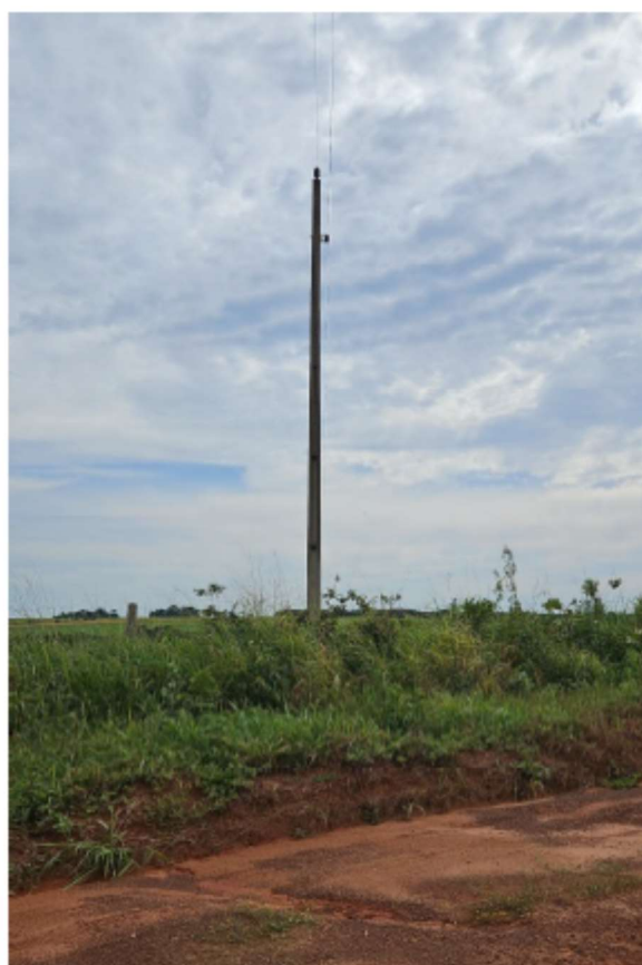
Figura 9 – Poste a ser remanejado – Estaca 62+0
