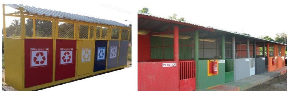
Figura 5 – Baías de Resíduos Obra LLUCENA INFRAESTRUTURA
