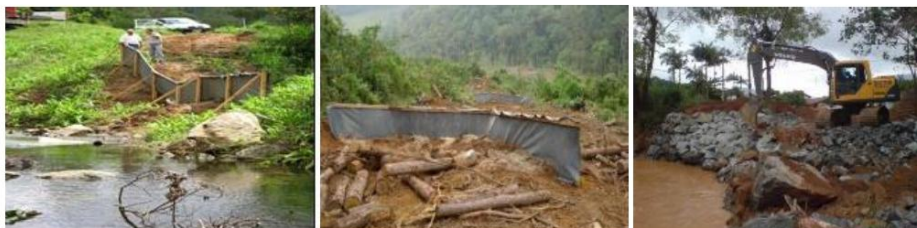
Figura 11 – Controles contra Carreamento de Sedimentos
