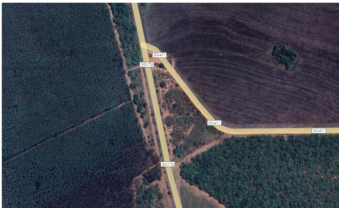
Interseção com a GO-174 (início do trecho)
