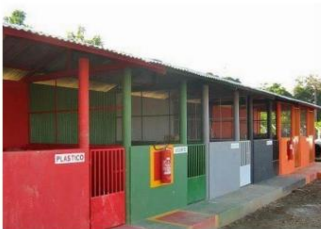
Exemplo Ilustrativo das Baías de Segregação dos Resíduos de Obra
