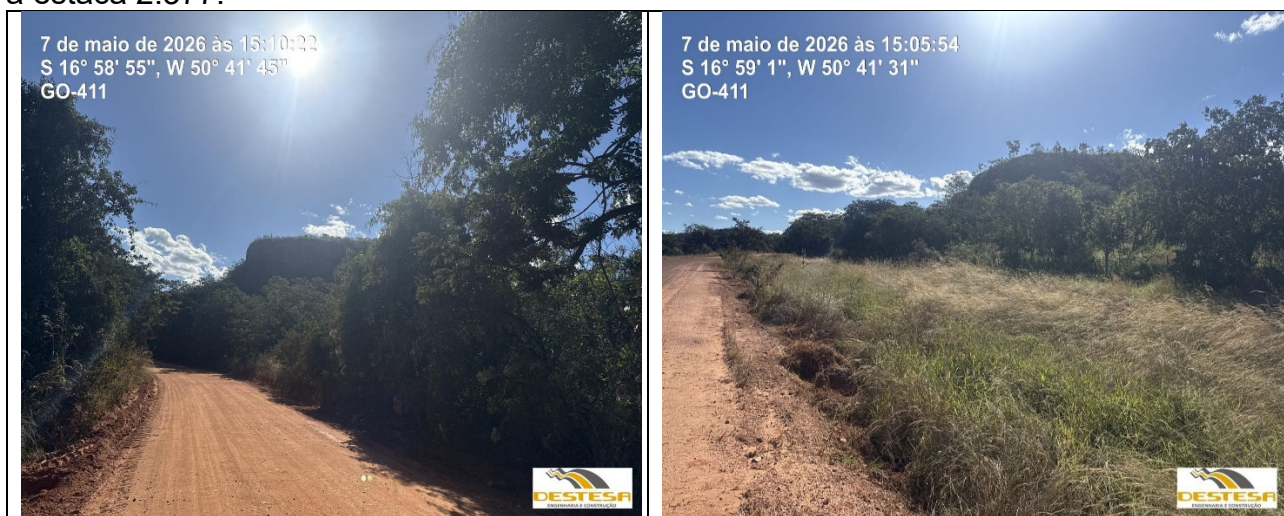
Fotos retirada do trecho, corte de Material de 3ª categoria, data 07/05/2026
