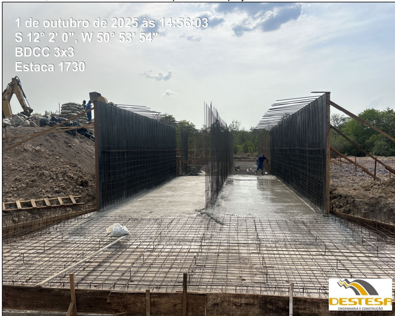
Fotos retirada da obra rodovia MT-100 de Novo Santo Antônio/MT, onde a empresa DESTESA ENGENHARIA está realizando obra de implantação e pavimentação,
