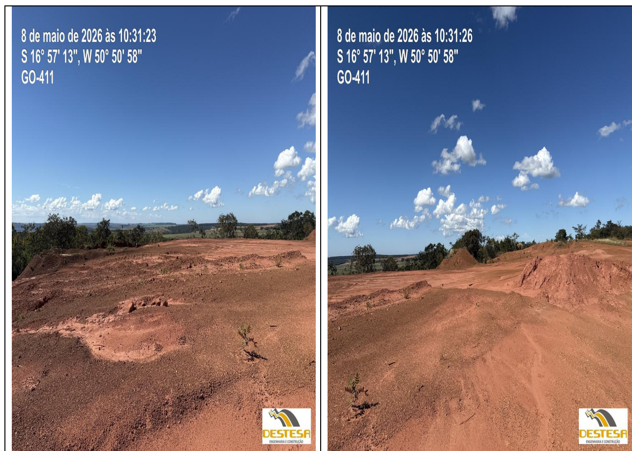
Fotos retirada do trecho, JAZIDA J1 - Projeto, data 08/05/2026
