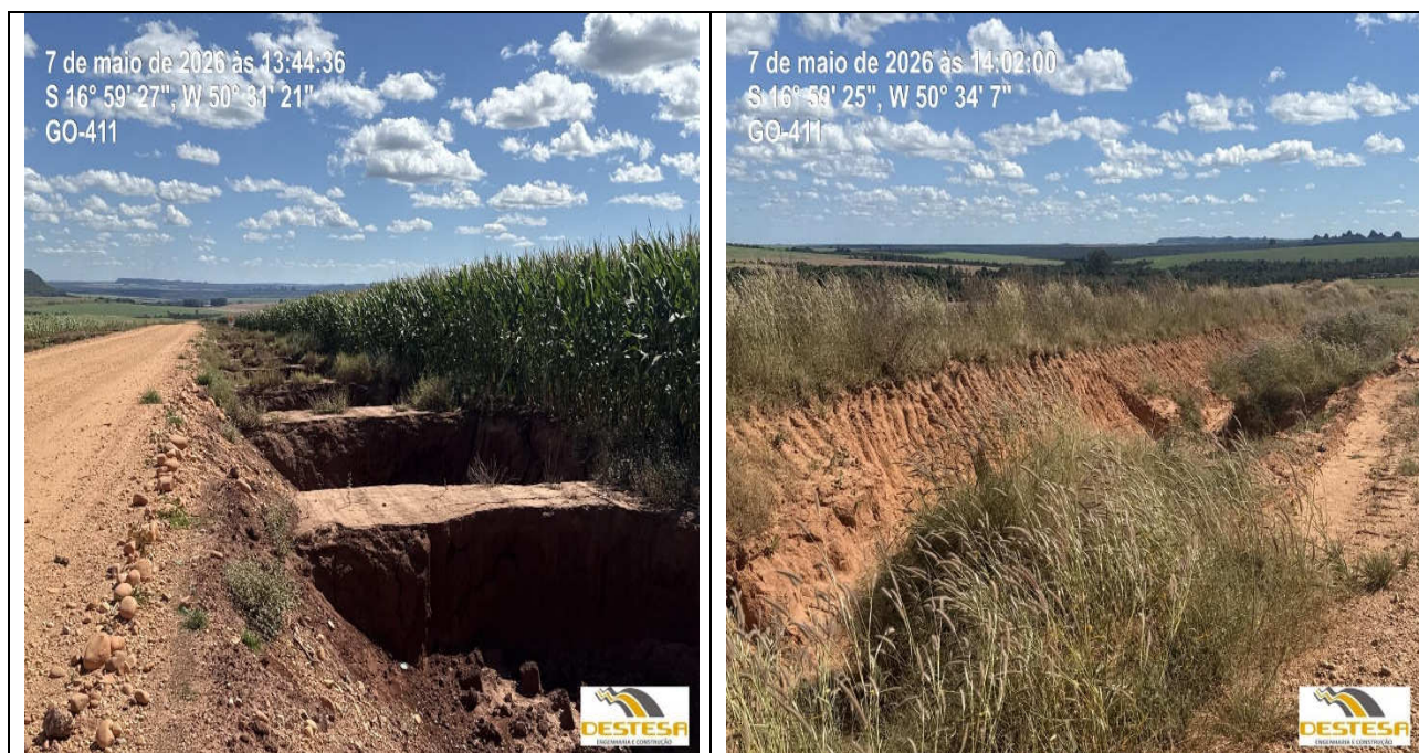
Fotos retirada do trecho de caixa de empréstimo já exploradas, durante a visita técnica de data 07/05/2026
