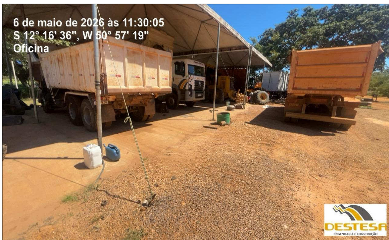
Foto da obra rodovia MT-100 de Novo Santo Antônio/MT, obra de implantação e pavimentação rodovia. Apoio Oficina
