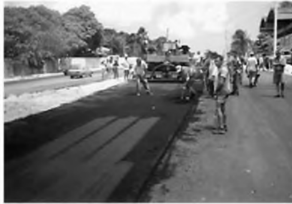
(b) Revestimento asfáltico sendo executado
