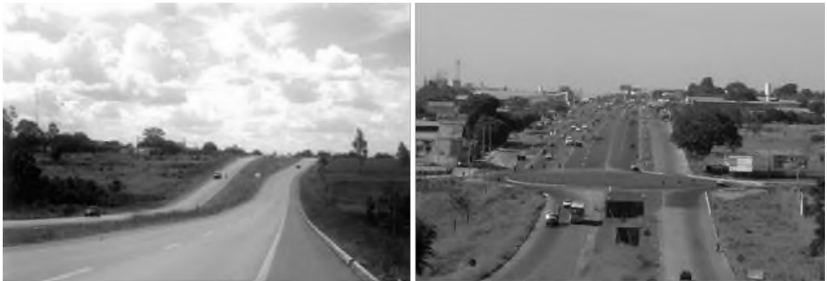
Figura 6—Duplicação rodovia GO-070 e implantação de vias marginais - Extensão: 8 km
