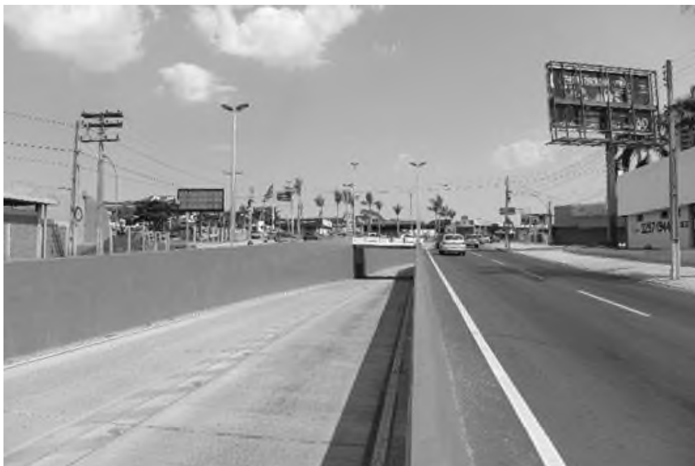
Figura 4 – Viaduto Interseção da Avenida Castelo Branco com Rodovia GO-060
