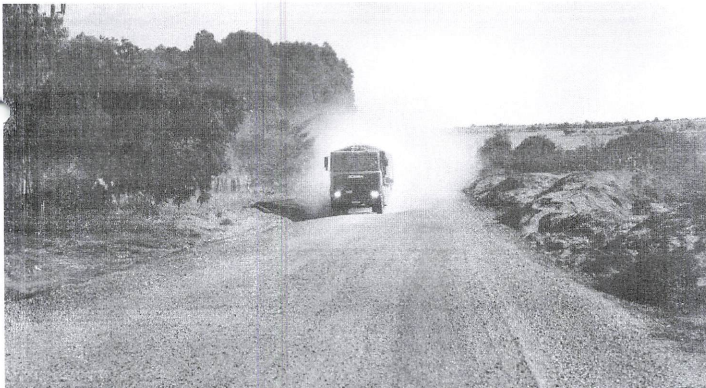
Trecho da rodovia MS-166 que será asfaltado (Foto: Saul Schramm - Governo MS)
