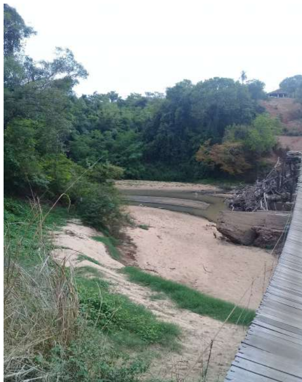
Figura 7.10: Aspecto da vegetação no entorno da ponte do Rio do Peixe.
