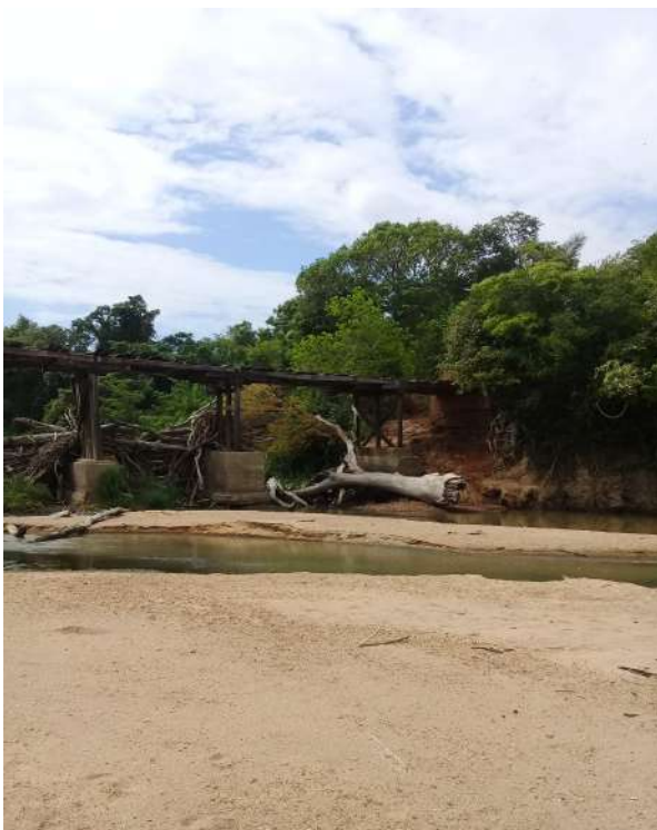
Figura 7.9: Aspecto da vegetação na ponte do Rio do Peixe.
