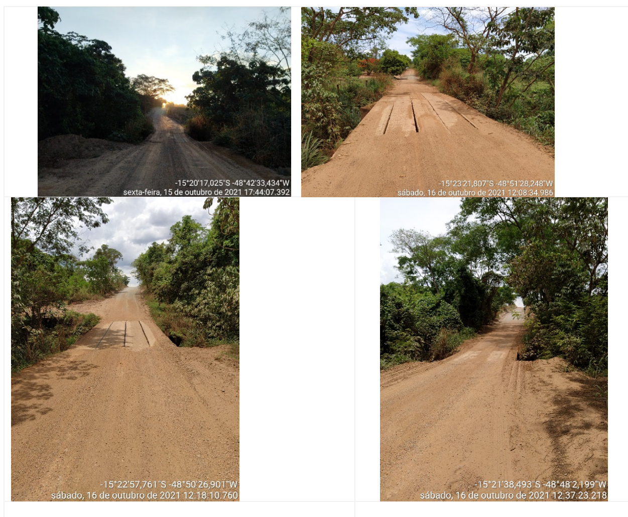
Obras de arte especiais do segmento rodoviário – pontilhões estreitos.
